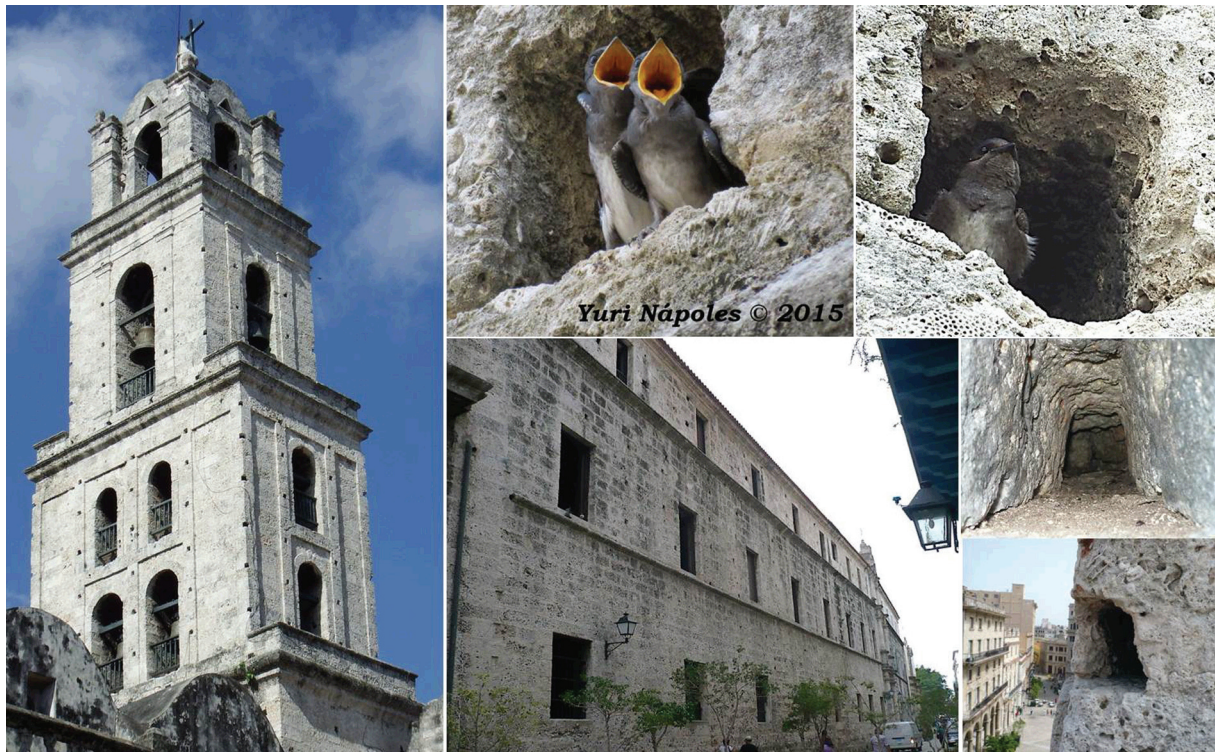
Figura 2. Cavidades disponibles en el Convento San Francisco de Asís, La Habana, Cuba producto del sistema de andamiaje utilizado durante su construcción. Todas las cavidades usadas por la Golondrina Azul Cubana ( Progne cryptoleuca ) se sitúan en las paredes externas de la edificación. Fotografías por Ianela García-Lau y Yuri Nápoles (2015).
